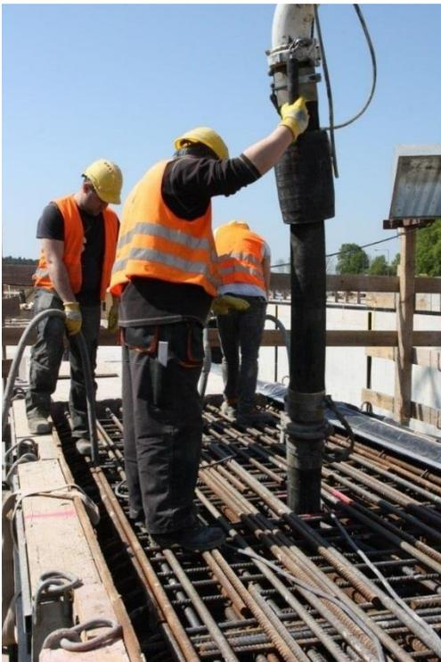
Der Schleusenkörper mit einer Länge von 190 m und einer Breite von 12,5 m ist monolithisch betoniert – bei 60.000 m<sup>3</sup> Beton eine große Herausforderung (Schwinden, Rissbreiten, Arbeitsfugen, Betonierbedingungen etc.).
